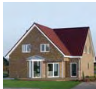
Haus Bremen House Bremen
