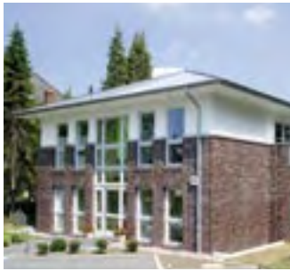
Haus Strasbourg House Strasbourg
